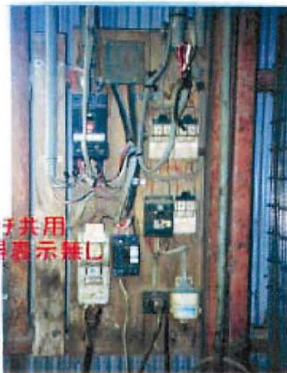
刃型スイッチは 表示電圧の60%以下で使用 完全投入 適正ヒューズ使用
